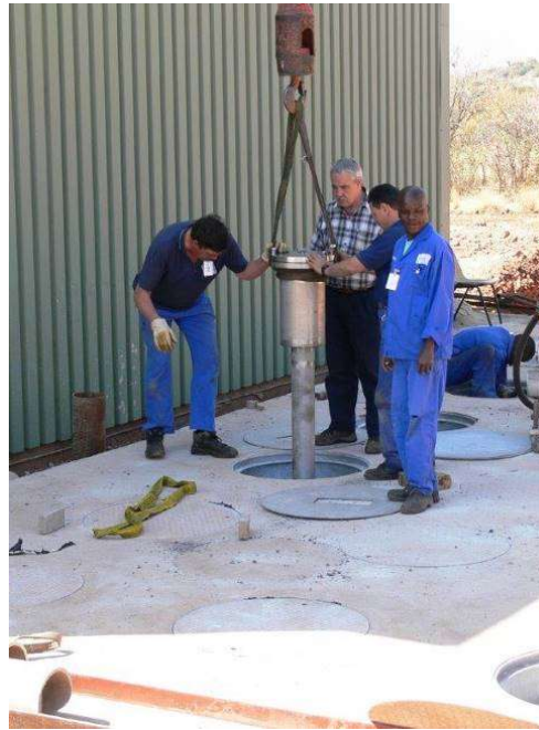
Figuur 3: 'n Nuwe SAFARI-1 stoorhouer wat tydens die 2006/7 uitbreiding in 'n boorgat laat sak word
