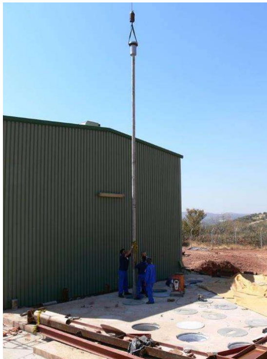
Figuur 2: Plasing van 'n nuwe SAFARI-1 stoorhouer in 'n boorgat tydens 2006/7 uitbreiding
