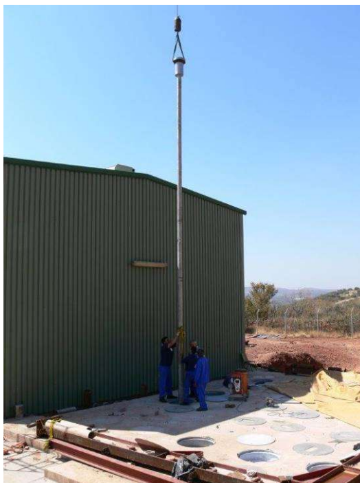
Setshwantsho 2: Go tsenngwa ga seketswana se seswa se se bolokang dilo sa SAFARI-1 mo mosimeng o o borilweng ka nako ya katoloso ya 2006/7
