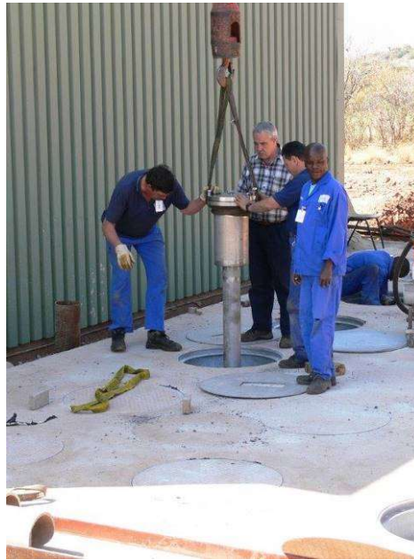
Setshwantsho 3: Sejana se seswa sa go boloka dilo sa SAFARI-1 se tsenngwa mo mosimeng o o borilweng ka nako ya katoloso ya 2006/7
